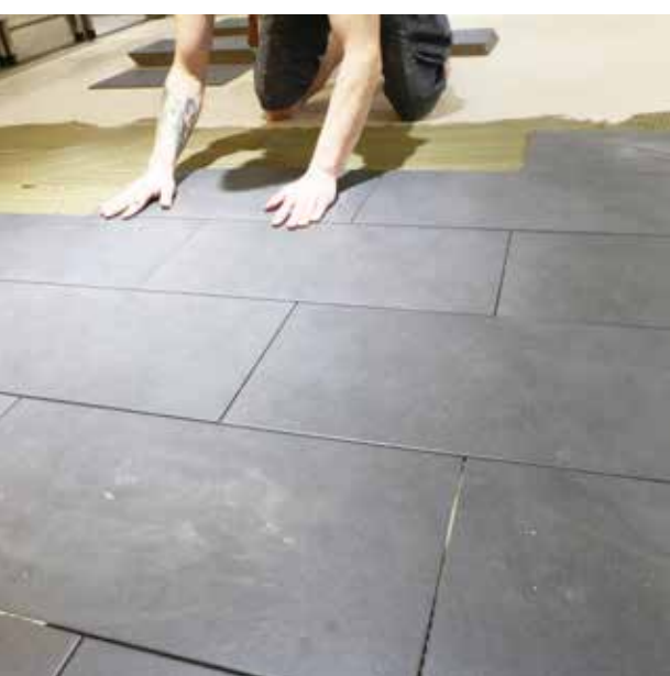
Oben: Das alte Stäbchenparkett wird herausgebrochen. Mitte: Die Ausgleichsmasse wird angemischt. Unten: Vor dem Tresen werden Fliesen verlegt.
