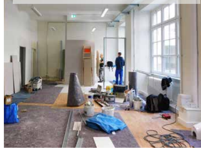
Oben: Die letzten Handwerksarbeiten in den Räumen der Lichtfabrik Mitte: Die Kabel-Gruppe sitzt auf gepackten Kisten Unten: Blick in den neuen Arbeitsraum der Kabel-Gruppe
